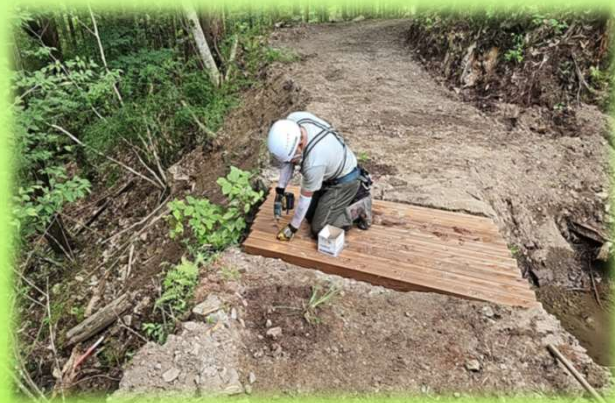
東海自然歩道の人道橋復旧
