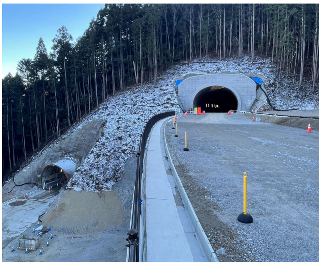
工事用のトンネル(左下)と新大名倉トンネル(右上)
