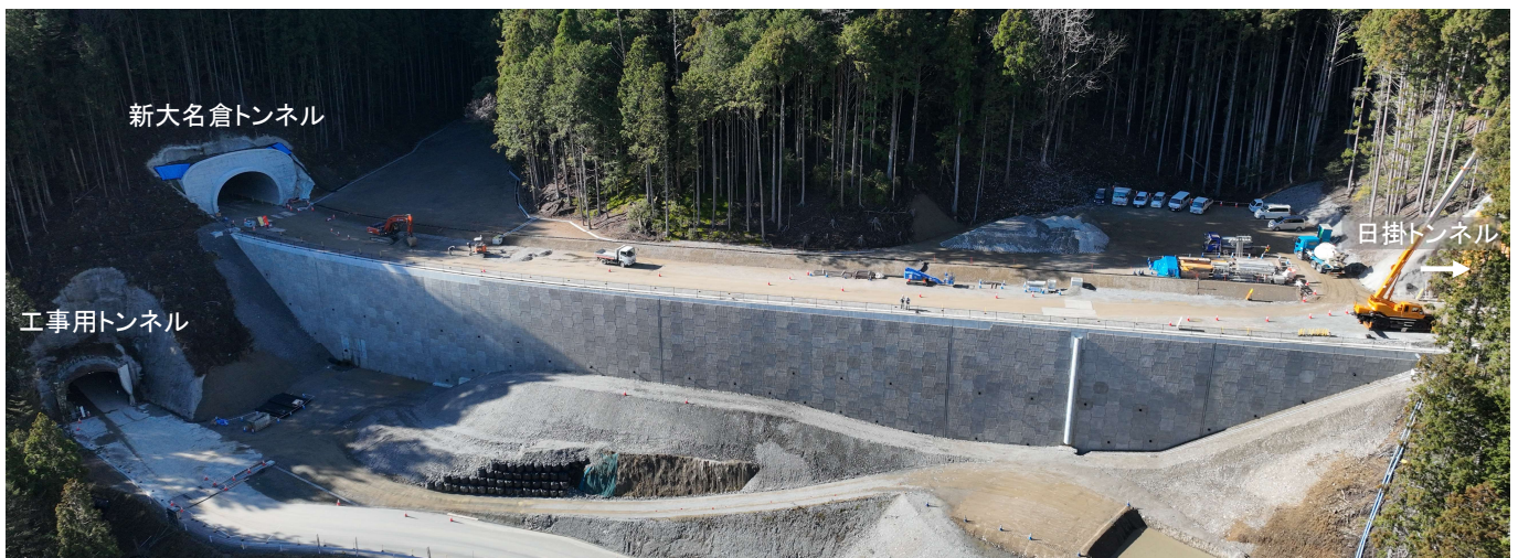
新大名倉トンネル～日掛トンネル周辺の遠景
