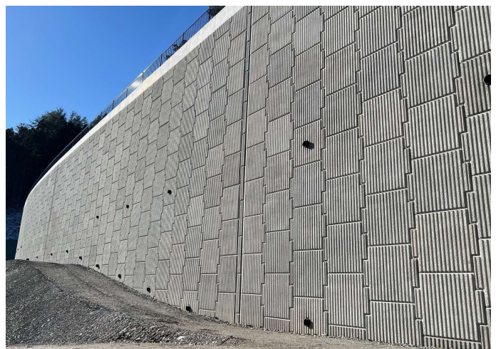
補強土壁でつくられている2つのトンネルをつなぐ道路
