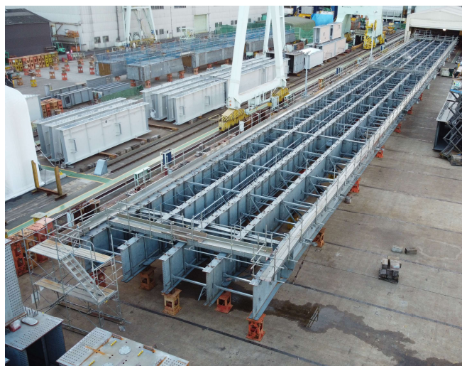
向島工場での仮組み立ての様子
