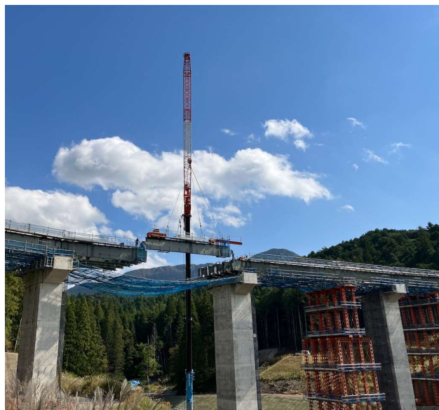
大型クレーンによる橋桁の架設の様子
