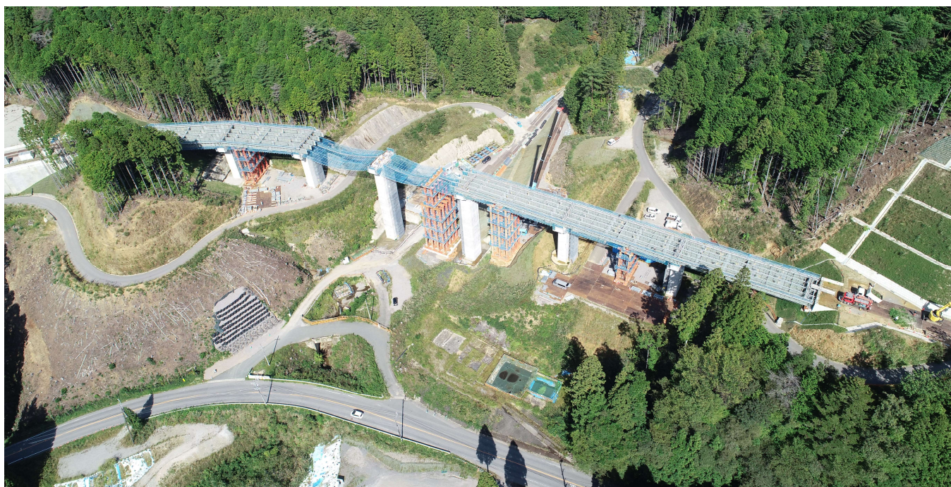
工事中の添沢橋の全景。手前の道路は現道の国道257号。（令和5年10月6日撮影）
