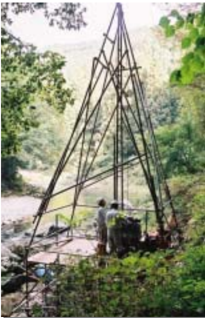
ボーリング調査（例）
