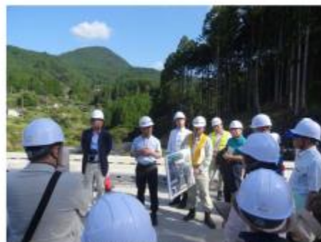
付替道路設楽横羽線の工事現場
