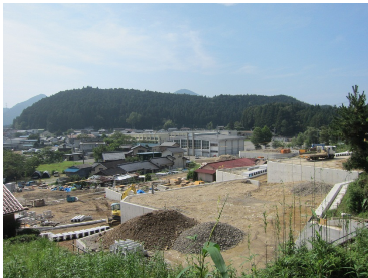
西貝津地区造成工事中 (平成25年7月撮影)
