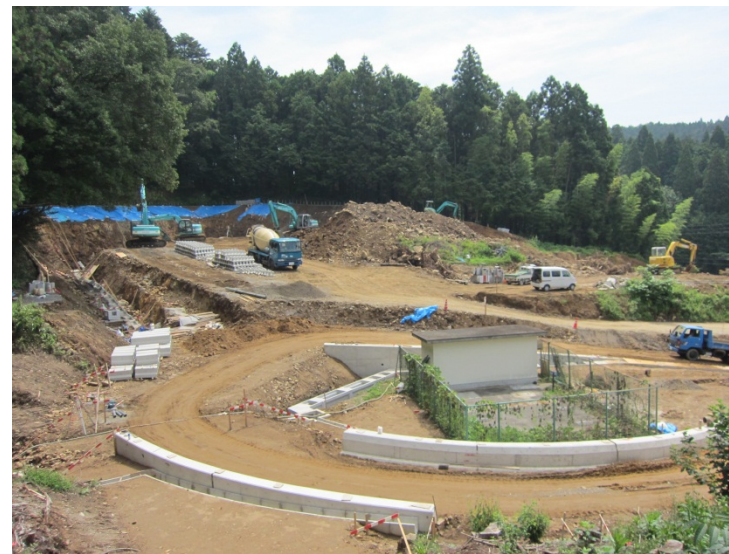
シウキ地区造成工事中 (平成25年7月撮影)
