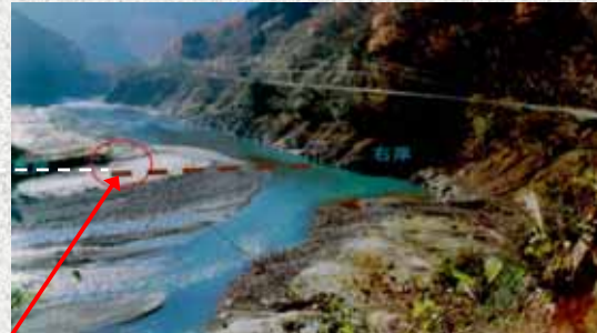
堆砂により埋没した鬼姫生橋 (平成11年)
