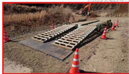
タイヤ洗浄機の設置
