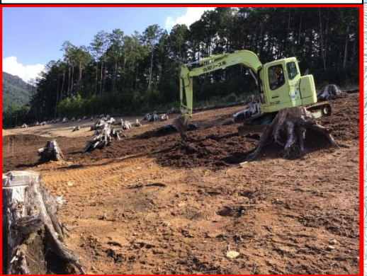
チップの敷均し
