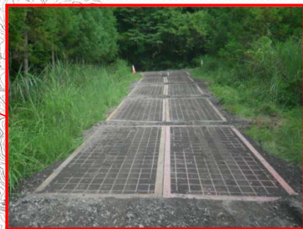
泥落としマットの設置
