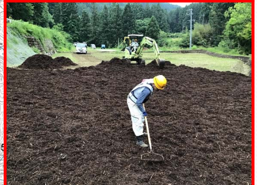
チップの敷均し
