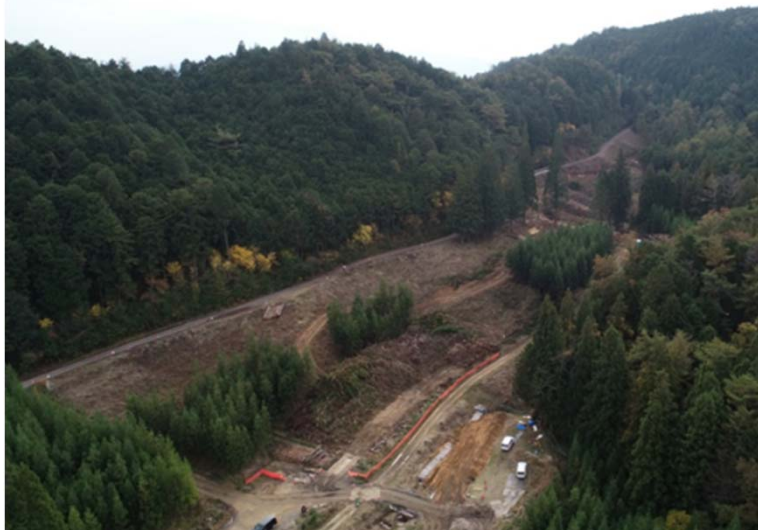
④道路整備工事(田口工区)
