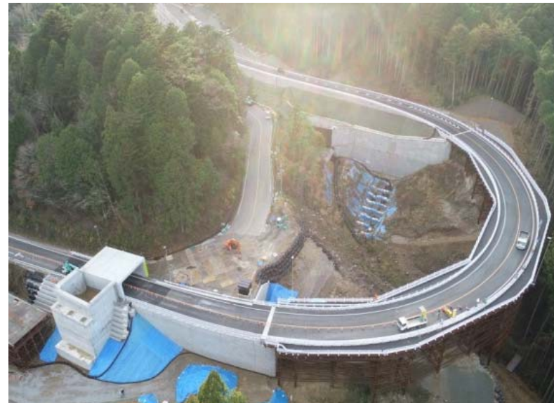
⑤設楽根羽線1号橋 橋台施工
