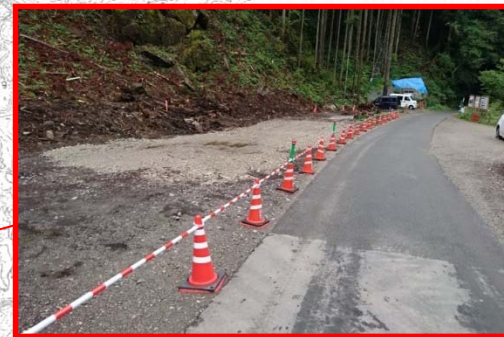
離合帯や駐車場の整備に再生砕石(RC-40)を使用。
