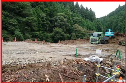
地山掘削箇所において泥を道路に持ち出さないために、掘削後ダンプ旋回場所等に早期に岩ずりを敷き均す等の工夫を実施
