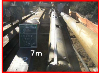
従来はケーシング12mであるが、騒音・振動が小さい7mのダウンザホールハンマーを採用(騒音・振動の発生の少ない工法の採用)
