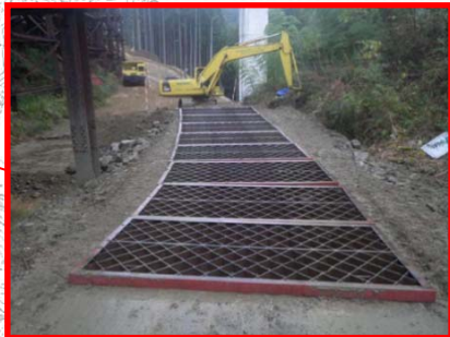
泥落とし鋼製網マットの設置
