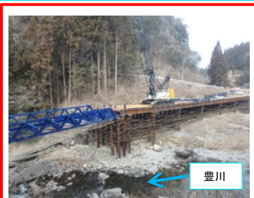
豊川 松戸橋下流付近 仮橋施工中
