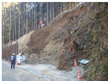
吐口法面 4段中3段目施工中
