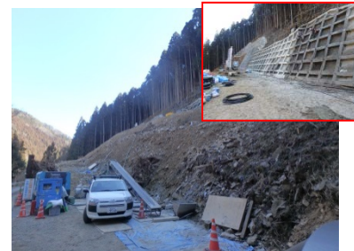
仮設備ヤード法面 3段中2段目施工中
