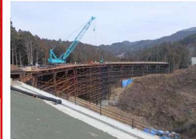
国道迂回路 仮橋施工中
