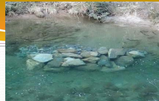
巨石投入による生息環境改善
