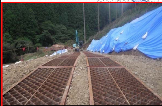
泥落シマットの使用
