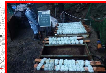
濁水処理水槽の設置
