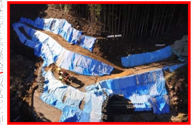
裸地面へのブルーシートの設置
