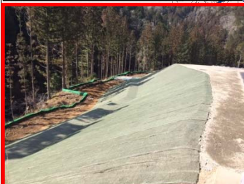
浸食防止マットの設置
