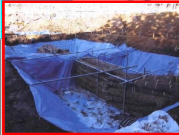
沈砂池の設置
