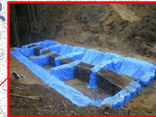
沈砂池の設置
