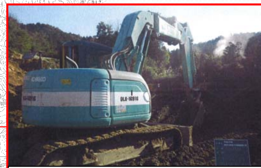
超低騒音型重機(バックホウ)の使用
