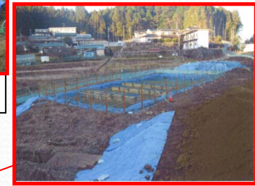
沈砂池の設置
