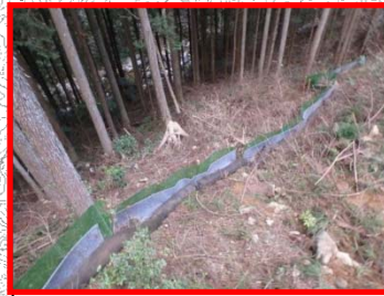
流砂止めの設置
