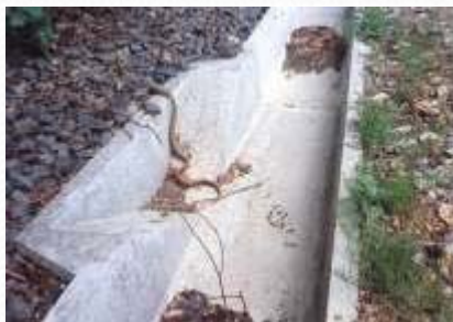
道路側溝における対策事例
