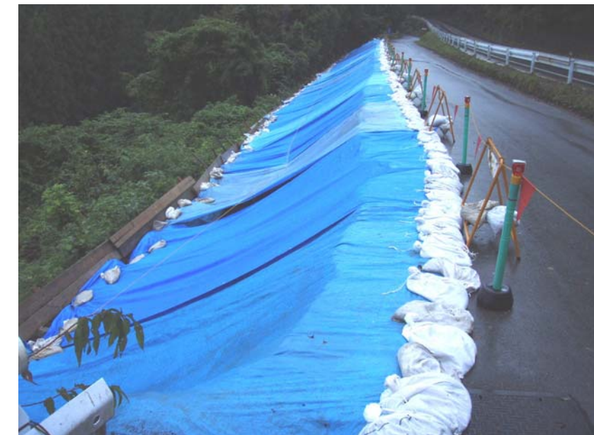
写真 法面からの濁水防止対策
