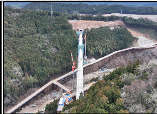
瀬戸設楽線5号橋から4号トンネル
