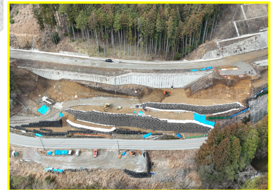
③八橋地区南部道路建設
