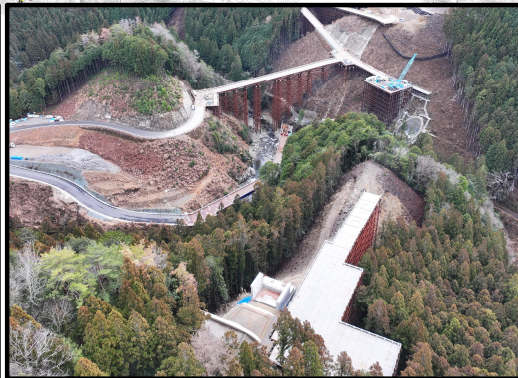
瀬戸設楽線2号トンネルから3号橋
