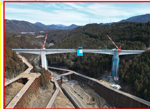
③5号橋PC上部工
