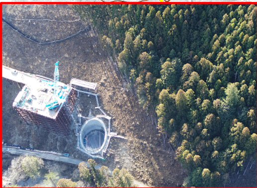
①R6・3号橋下部工
