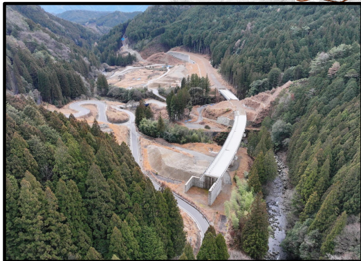
瀬戸設楽線1号橋から1号トンネル
