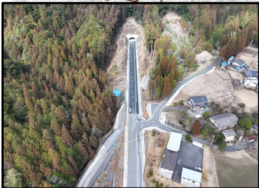
設楽根羽土工3工区から1号トンネル
