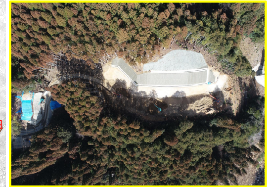
④川向地区道路建設
