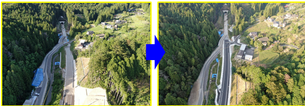
②令和5年度 設楽ダム八橋地区道路建設工事 (令和6年5月完成)
