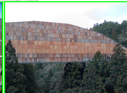
②設楽大橋塗替工事
