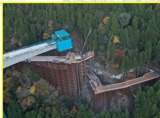
②松戸地区道路建設
