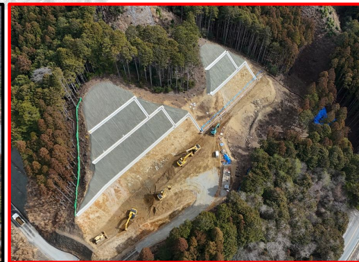
①田口地区道路建設
