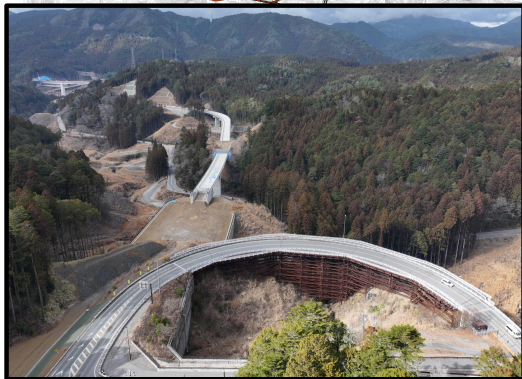
257号起点から設楽大橋
