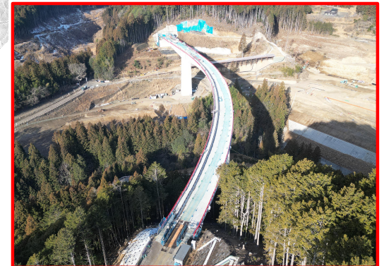
③ 4号橋PC上部工
