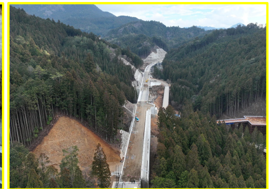
②長江地区道路建設
