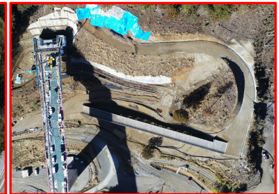
② 4号橋下部工(A2橋台)
