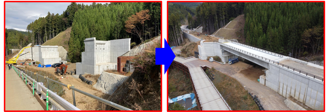
⑥令和5年度 設楽ダム設楽根羽線4号橋PC上部工事 (令和6年11月完成)
