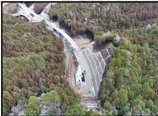
設楽根羽線1号トンネルから4号橋
