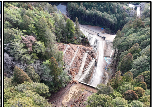
5号トンネルから国道257号
