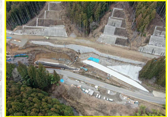
④八橋地区北部道路建設
