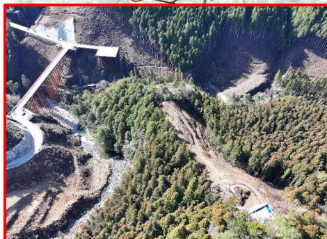
④3号橋下部工
