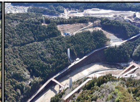
瀬戸設楽線5号橋から5号トンネル
