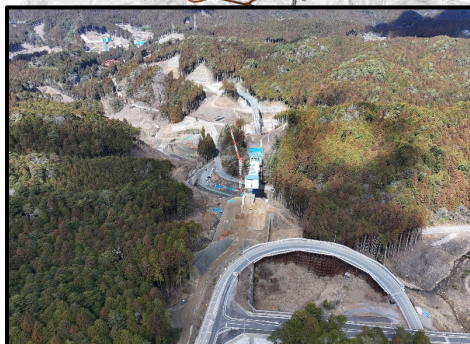
257号起点から設楽大橋
