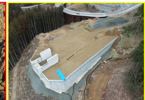
②田口地区道路建設(田口工区)
