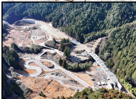
瀬戸設楽線1号橋から1号トンネル
