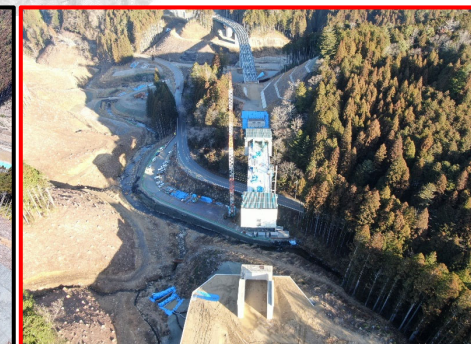
①1号橋PC上部工(起点側より)
