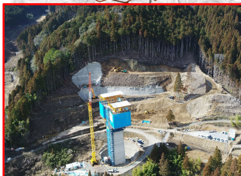
③4号橋下部工
