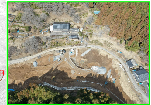
⑤延坂地区盛土整備(小松工区)
