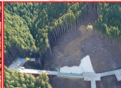
⑤松戸地区橋梁下部工
