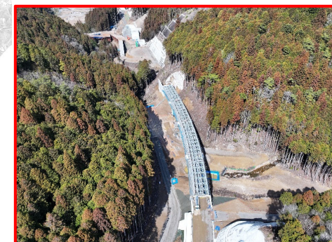
②3号橋鋼上部工
