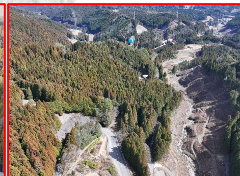
⑤川向地区道路建設
