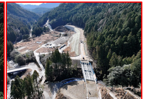
②2号橋鋼上部工
