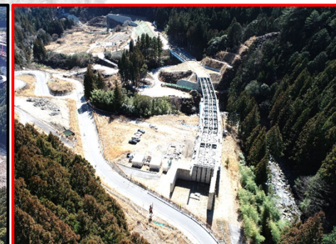
①大名倉地区床版（1号橋）
