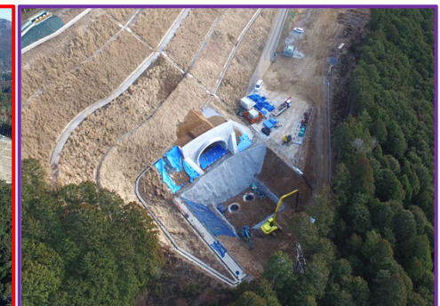
⑦4号トンネル（起点側）
