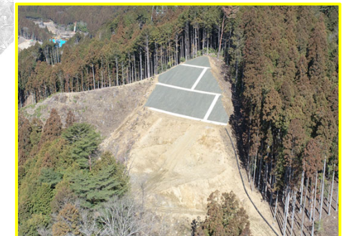
②田口地区道路建設(奴田工区)
