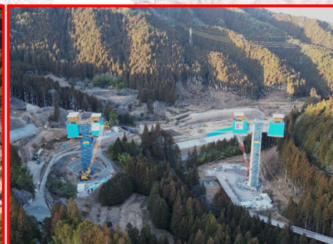
④4号橋PC上部工
