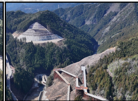
ダム本体施工箇所
