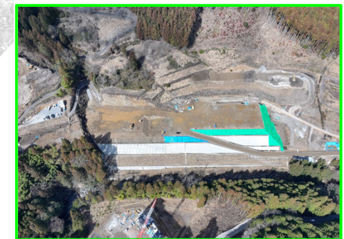
⑤延坂地区盛土整備(延坂工区)
