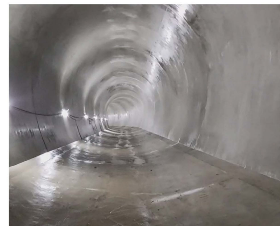
洗浄後トンネル内部状況
