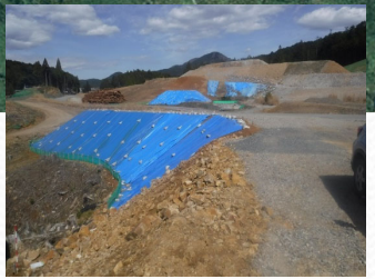
法面のシート養生状況
