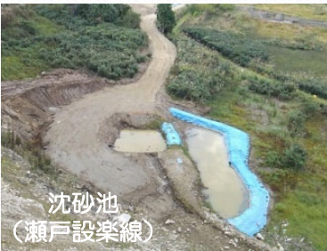
法面のシート養生状況
