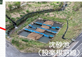
沈砂池 (設楽根羽線)
