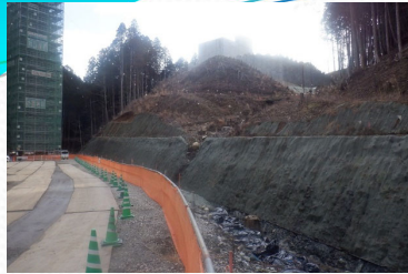
法面のシート養生状況
