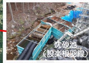
沈砂池 (設楽根羽線)
