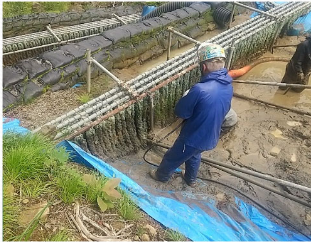
フィルター材の清掃状況 (バキューム処理)
