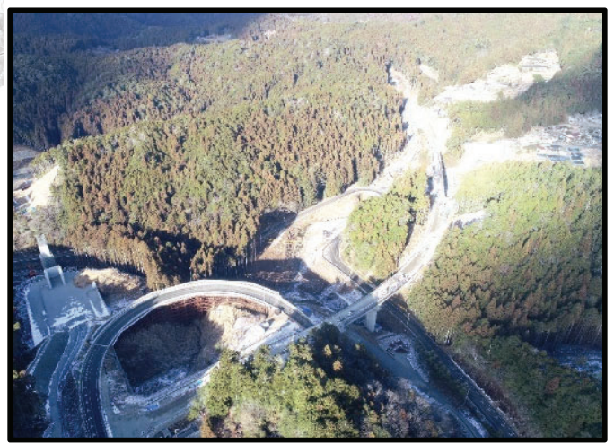
設楽根羽線起点から1号トンネル
