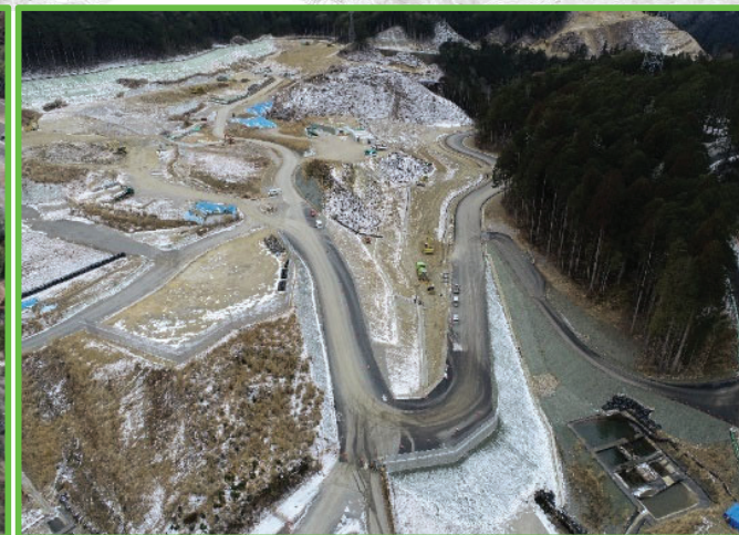
⑧清崎地区盛土
