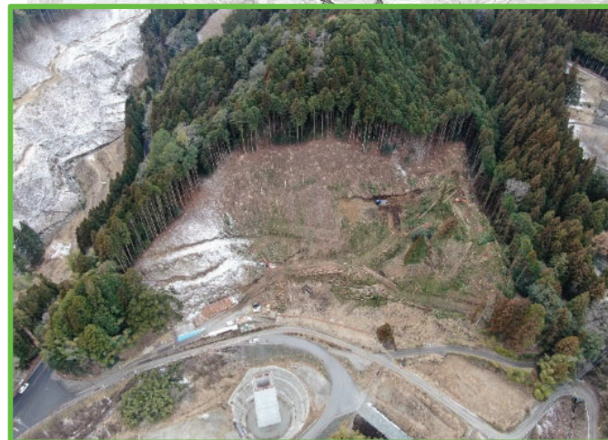
⑦R4貯水池斜面对策 (川向工区)
