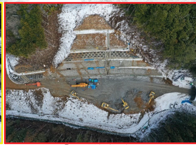
②3号橋左岸下部工
