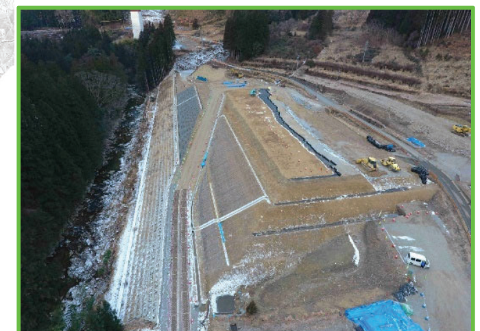
⑪延坂地区盛土
