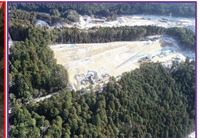
③ 4号トンネル（起点側）
