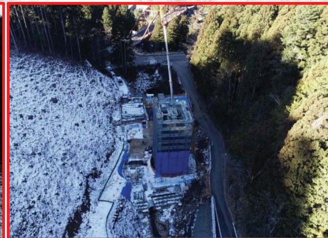
②3号橋下部工
