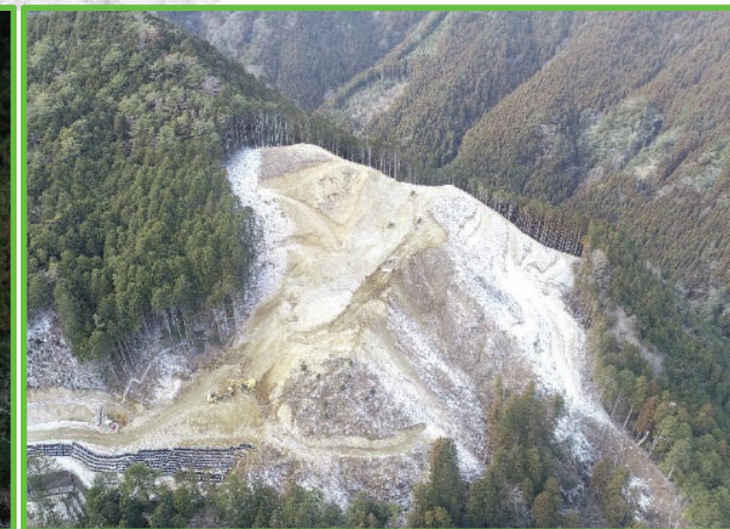
② 左岸頂部掘削
