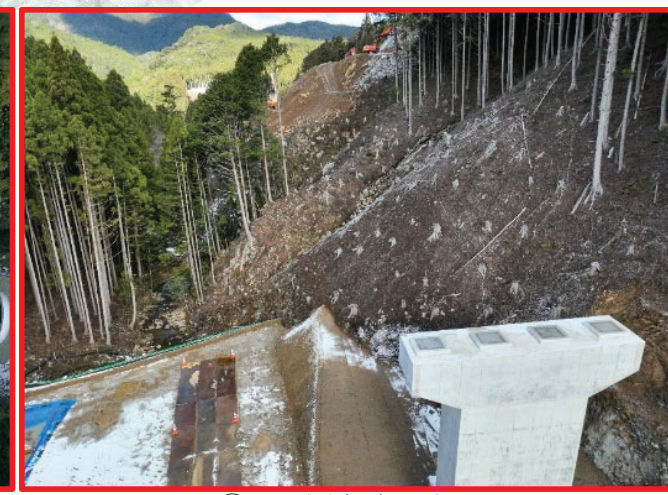
③3号橋右岸下部工
