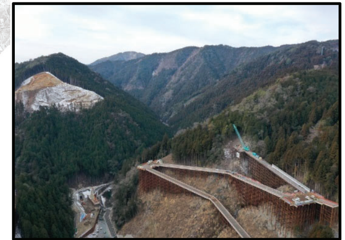
ダム本体施工箇所
