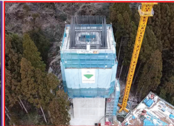
② 5号橋下部工（右岸）
