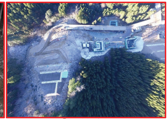
④4号橋下部工
