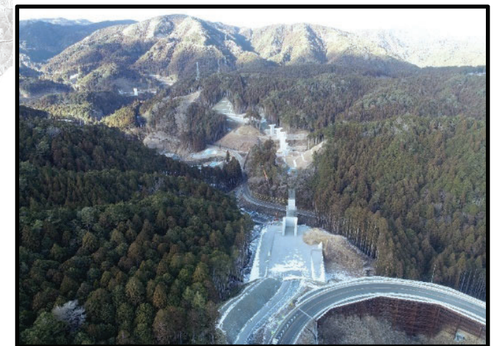
257号起点から設楽大橋
