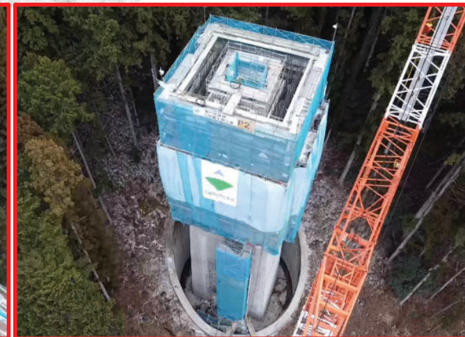
② 5号橋下部工（左岸）
