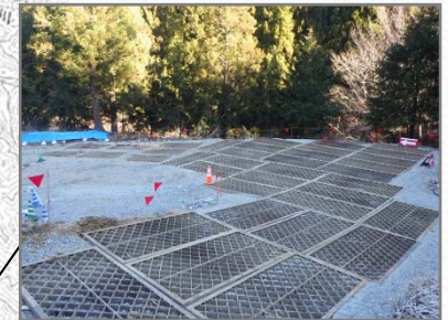
鋼製ロードマットの設置
