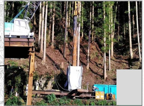
防音シートの使用
