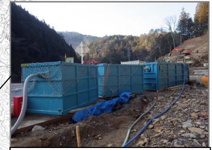
仮設沈砂池 工事用道路
