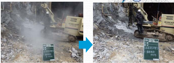
吸引機による集塵(右:使用時)
