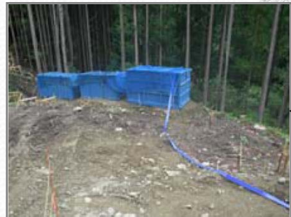
仮設沈砂池 瀬戸設楽線
