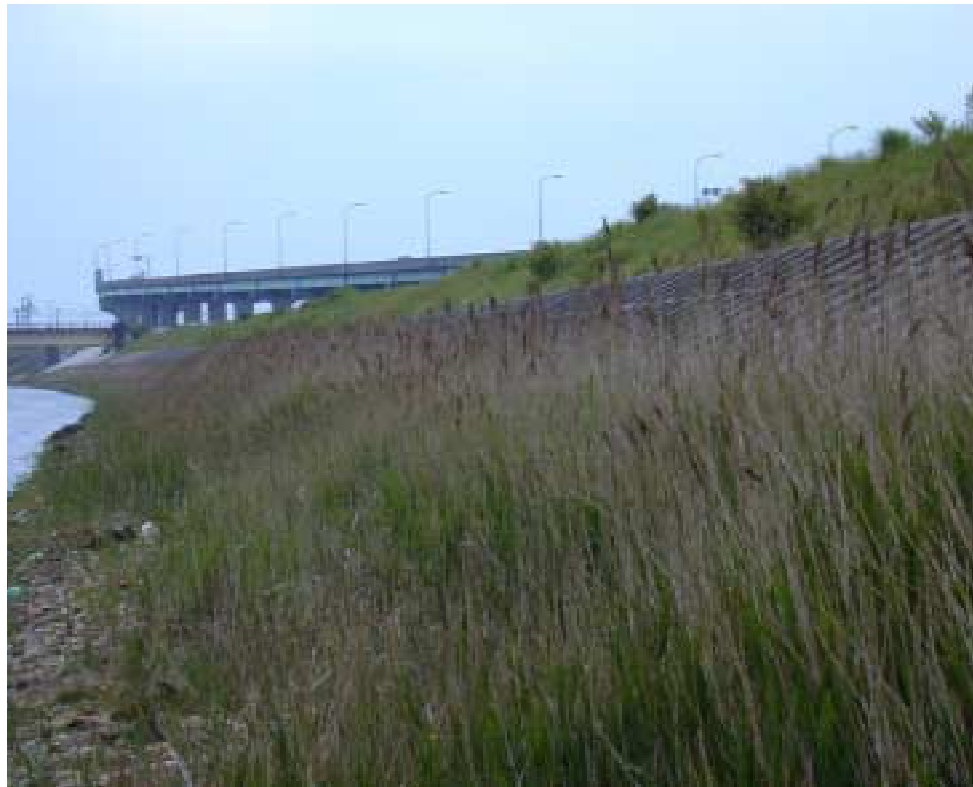
護岸前面に移植したヨシの生育状況 (豊川放水路：小坂井町平井)
