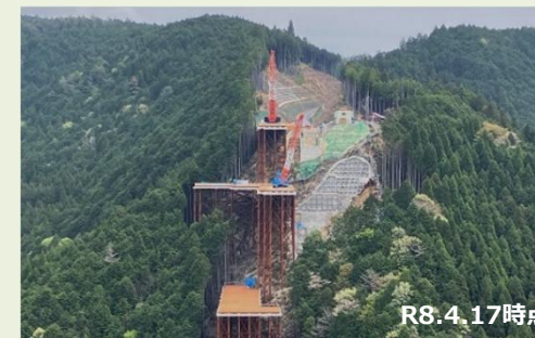
付替国道418号(仮称)7号橋
