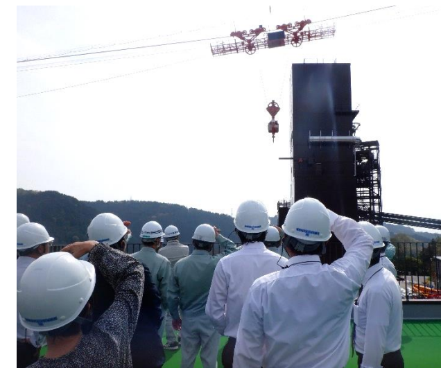
コンクリートを運搬するケーブルクレーン
