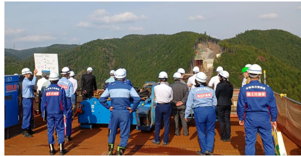
付替国道418号7号橋(仮称)の建設現場
