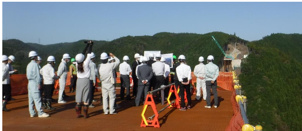
付替国道418号7号橋(仮称)の建設現場
