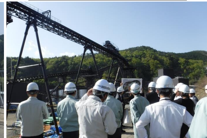
ダム用コンクリート骨材の製造設備
