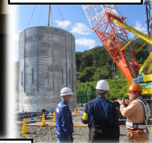
安全パトロール実施状況
