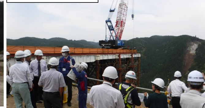
国道418号7号橋 建設現場
