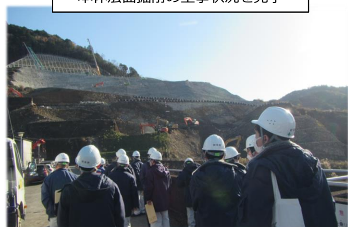
本体法面掘削の工事状況を見学
