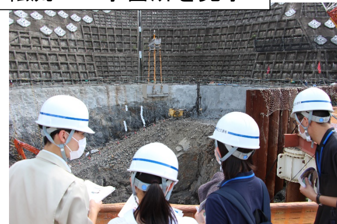
転流工工事箇所を見学
