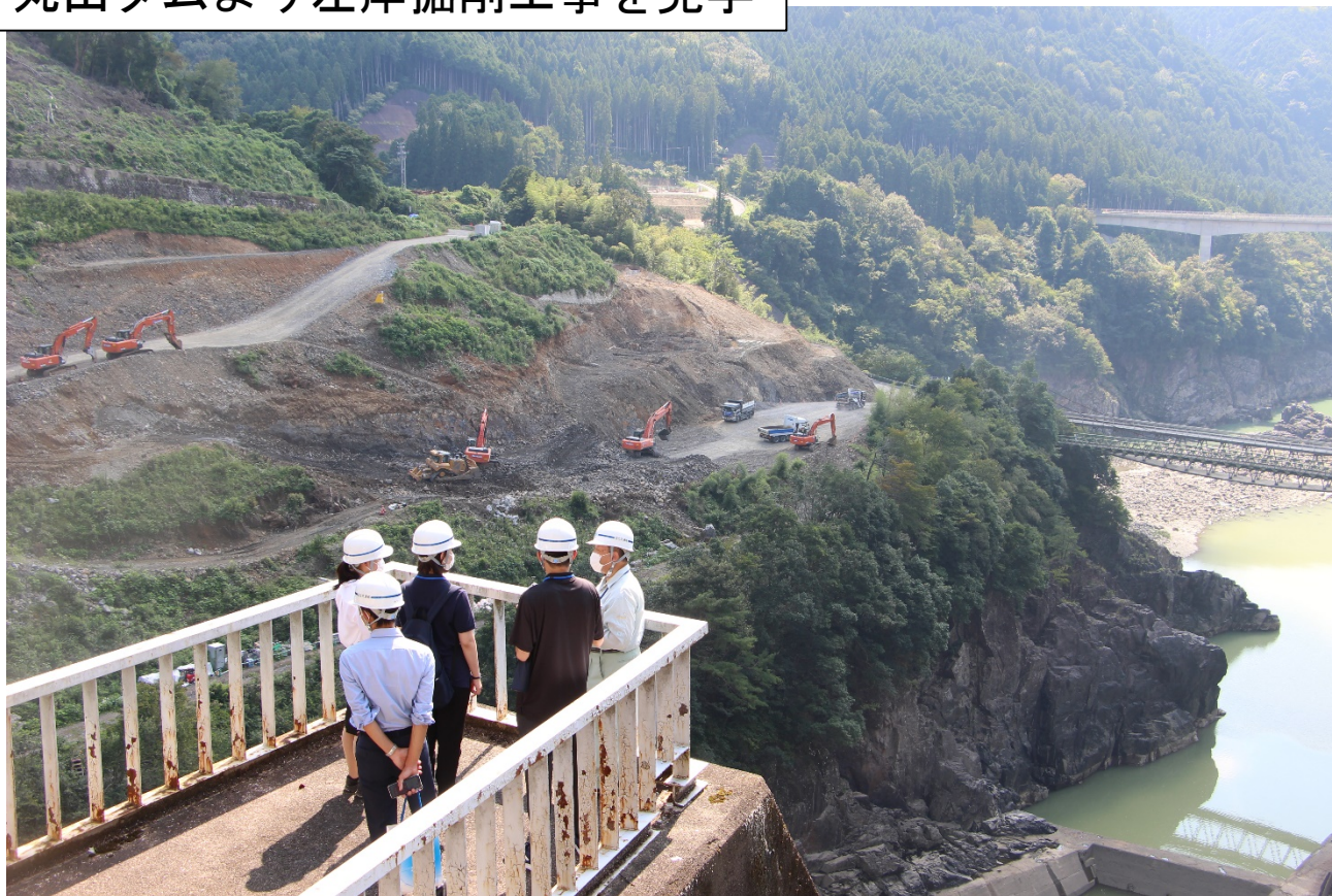
丸山ダムより左岸掘削工事を見学
