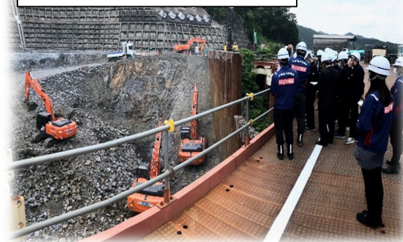
転流工にて施工概要説明
