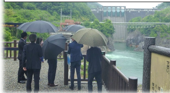
新展望台「まるっとテラス」より 丸山ダムの全景及び転流工を見学
