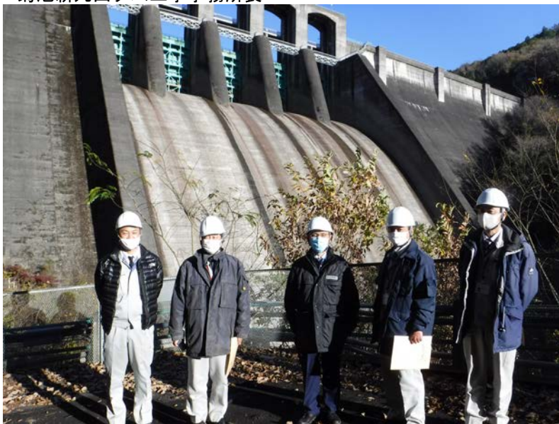
丸山ダム直下にて（中央が藤本恵司県議）
