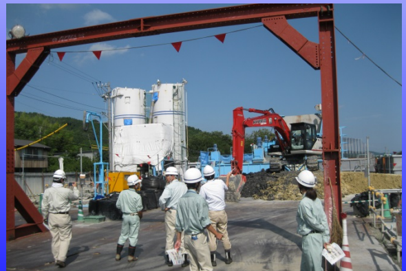
廃坑に充填するための材料や配合プラントの視察
