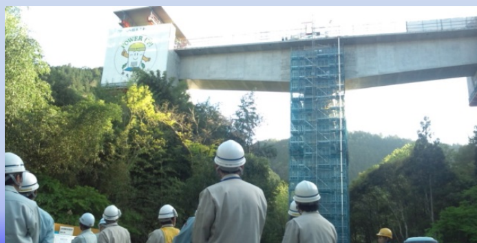
新丸山ダムの付替道路工事（新小和沢橋）の視察状況
