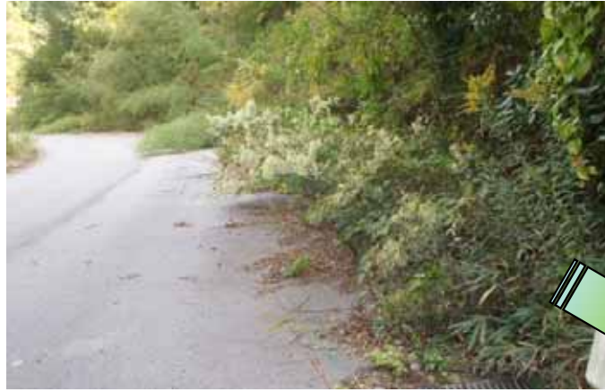
① 原石山線 排水施設清掃・除草作業
