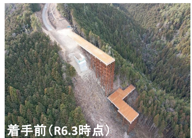
①令和5年度 新丸山ダム国道418号7号橋仮橋工事 3段目の仮橋が約14m伸びました。
