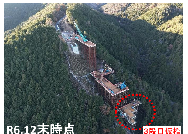
①令和5年度 新丸山ダム国道418号7号橋仮橋工事 3段目の仮橋が約14m伸びました。
