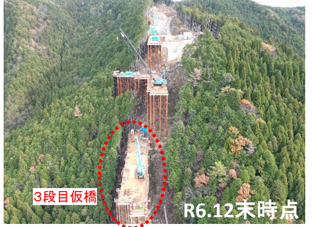
②令和4年度 新丸山ダム国道418号7号橋飯地下部工事 3段目の仮橋が約6m伸びました。
