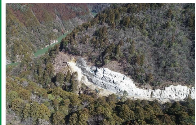
②R4新丸山ダム大西瑞浪線日吉地区道路建設工事 (令和6年3月完了)
