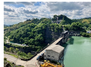
写真D 堤体(左岸より右岸を望む)
