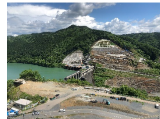
写真B 堤体(右岸より左岸を望む)
