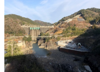
写真A 堤体(下流より上流を望む)
