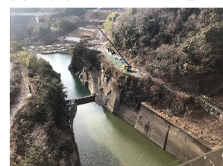
写真C 堤体(上流より下流を望む)
