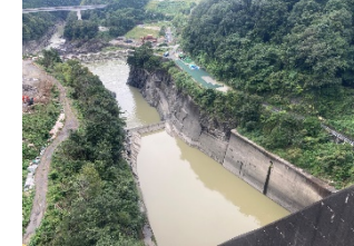
写真C 堤体(上流より下流を望む)
