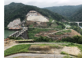
写真B 堤体(右岸より左岸を望む)
