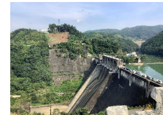
写真D 堤体(左岸より右岸を望む)
