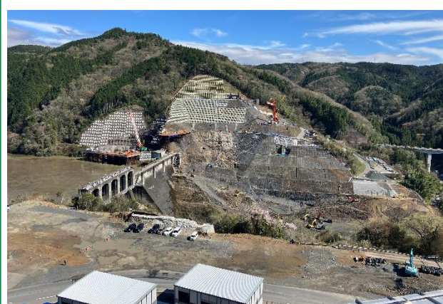
② 堤体左岸
