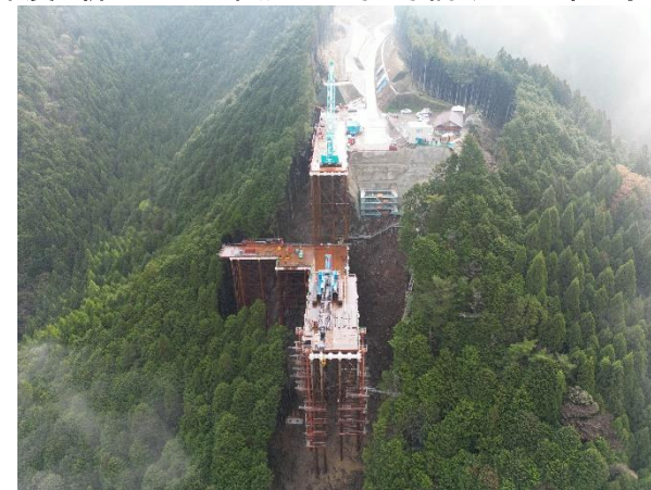
②令和4年度 新丸山ダム国道418号7号橋飯地下部工事(R6.4末時点)
