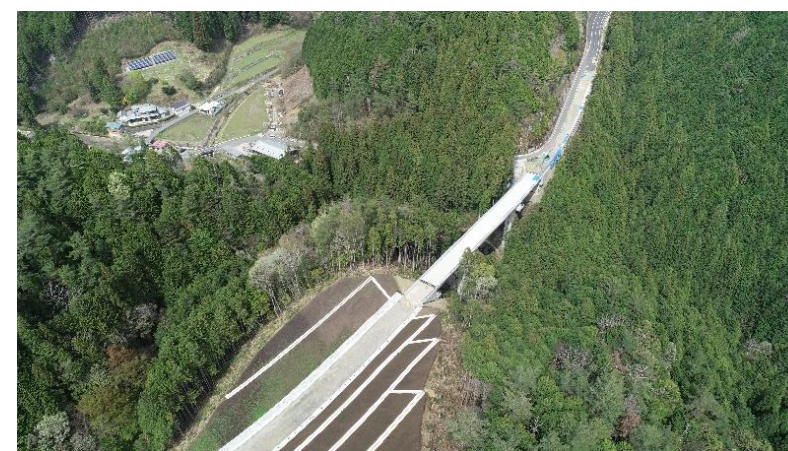
③令和5年度 新丸山ダム国道418号五明地区道路建設工事(R6.4末時点)
