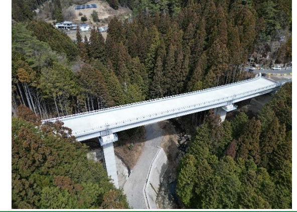
⑤R4新丸山ダム国道418号8号橋PC上部工事 (令和6年3月完了)
