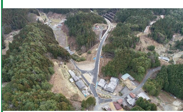
④R5新丸山ダム国道418号五明地区道路建設工事
