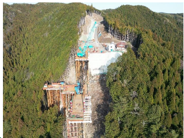
③R4新丸山ダム国道418号7号橋飯地下部工事
