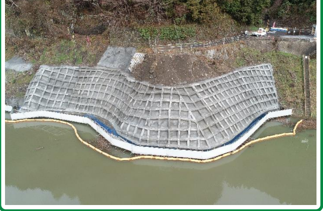
⑤R5新丸山ダム左岸管理用道路整備工事 (令和6年 3月完了予定)
