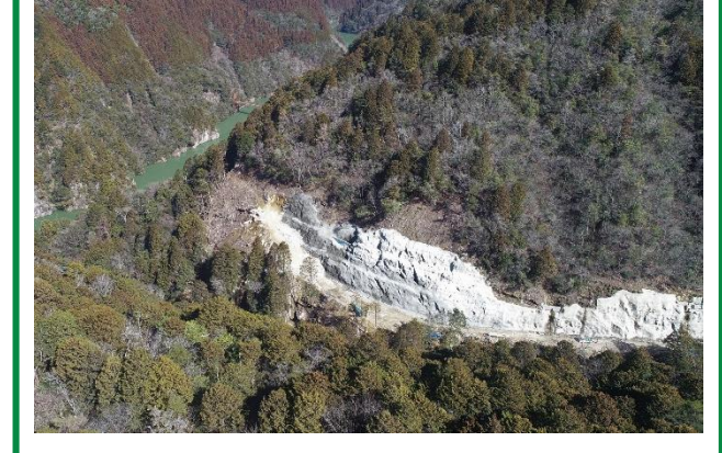
②R4新丸山ダム大西瑞浪線日吉地区道路建設工事 (令和6年3月完了予定)
