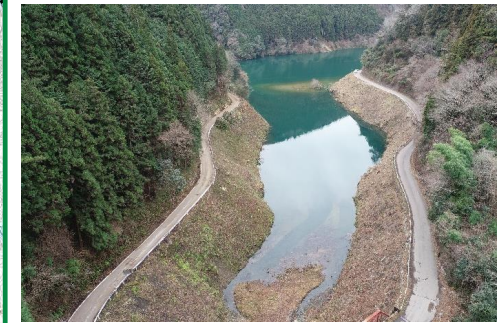
⑤R5新丸山ダム貯水池中流部伐採工事
