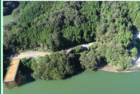
②R5新丸山ダム貯水池中流部伐採工事
