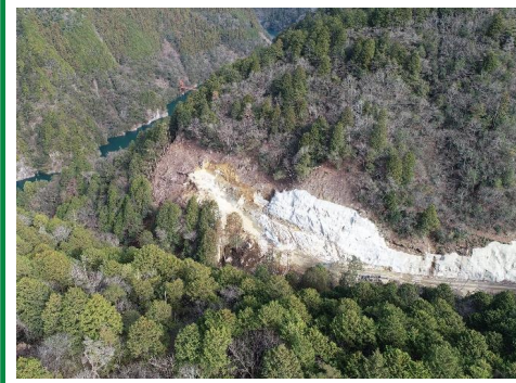
③R4新丸山ダム大西瑞浪線日吉地区道路建設工事
