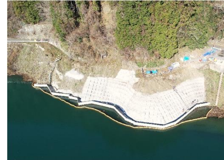
③R4新丸山ダム左岸管理用道路整備工事
