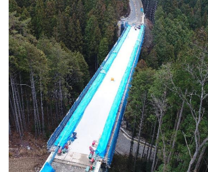
④R4新丸山ダム国道418号8号橋PC上部工事
