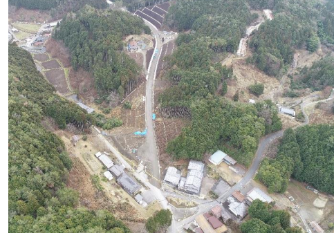
③R5新丸山ダム国道418号五明地区道路建設工事
