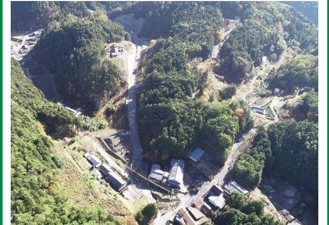
③R5新丸山ダム国道418号五明地区道路建設工事
