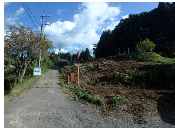
②R5新丸山ダム十日神楽地区道路建設工事
