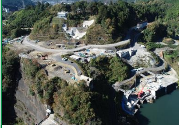
③ 堤体右岸
