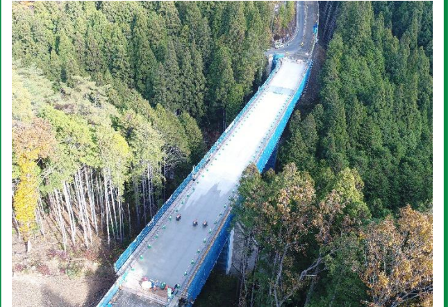
④R4新丸山ダム国道418号8号橋PC上部工事
