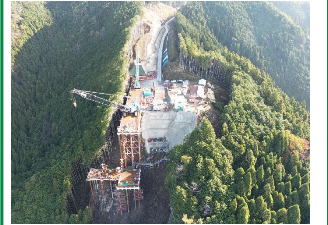
②R4新丸山ダム国道418号7号橋飯地下部工事
