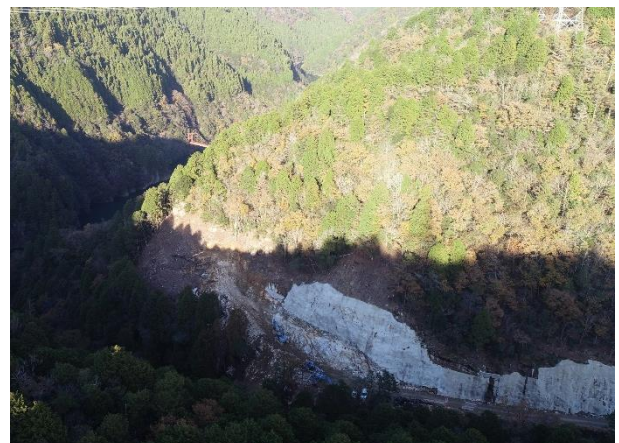
③R4新丸山ダム大西瑞浪線日吉地区道路建設工事
