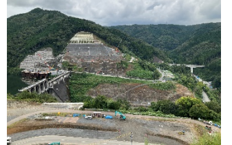
写真B 堤体(右岸より左岸を望む)
