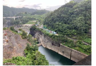
写真C 堤体(上流より下流を望む)
