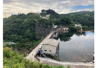
写真D 堤体(左岸より右岸を望む)
