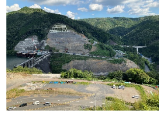
写真B 堤体(右岸より左岸を望む)
