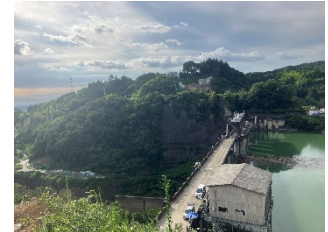
写真D 堤体(左岸より右岸を望む)
