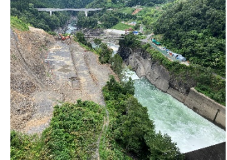
写真C 堤体(上流より下流を望む)
