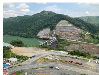
写真B 堤体(右岸より左岸を望む)
