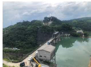
写真D 堤体(左岸より右岸を望む)
