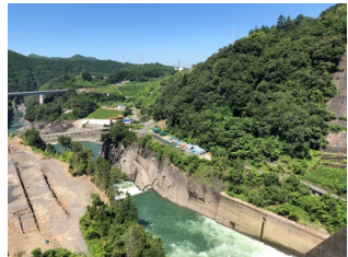
写真C 堤体(上流より下流を望む)
