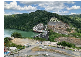
写真B 堤体(右岸より左岸を望む)
