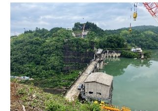
写真D 堤体(左岸より右岸を望む)
