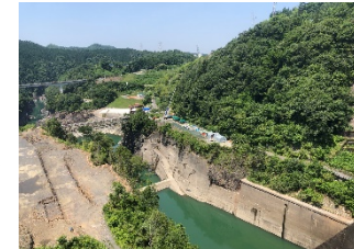
写真C 堤体(上流より下流を望む)
