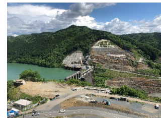
写真B 堤体(右岸より左岸を望む)
