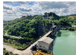
写真D 堤体(左岸より右岸を望む)
