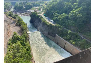
写真C 堤体(上流より下流を望む)
