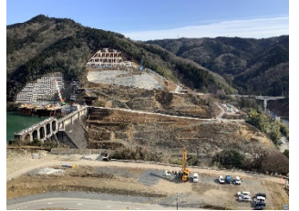
写真B 堤体(右岸より左岸を望む)
