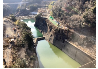
写真C 堤体(上流より下流を望む)
