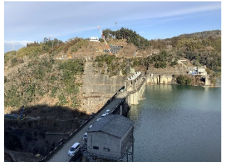
写真D 堤体(左岸より右岸を望む)
