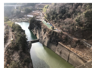
写真C 堤体(上流より下流を望む)
