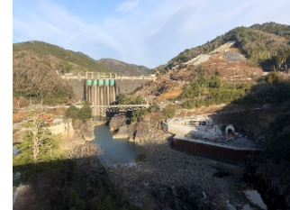
写真A 堤体(下流より上流を望む)
